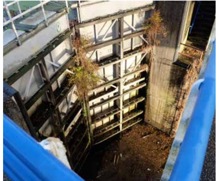
Sluis Apeldoorns Kanaal overbrugt 7 meter
